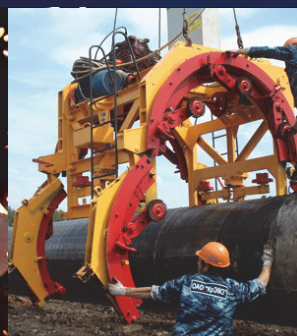
Изоляция и переизоляция труб
