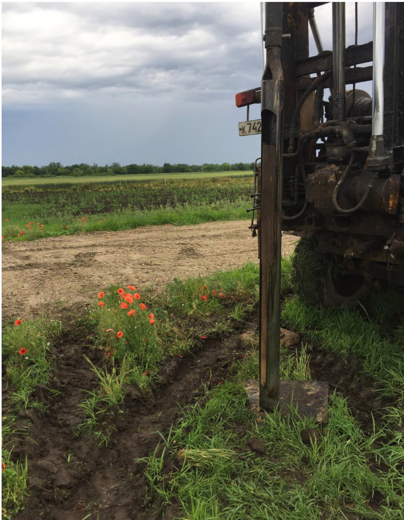
Фото 4 (общий вид площадки и трассы строительства)
