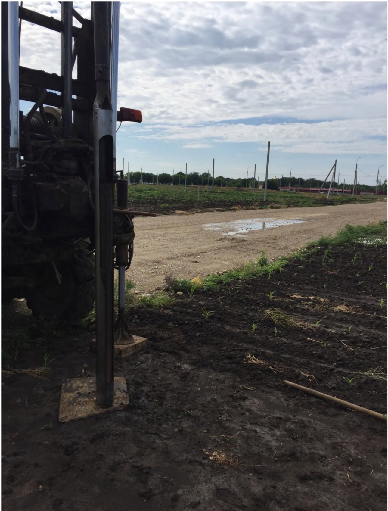
Фото 5 (общий вид площадки и трассы строительства)
