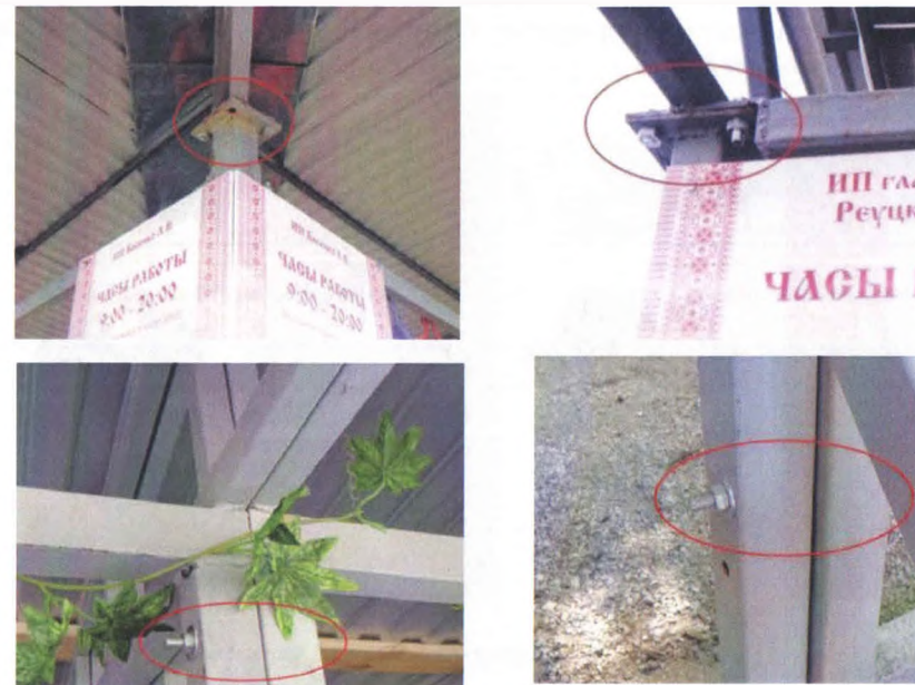
Рис. 28 – Крепежные элементы торговых конструкций
